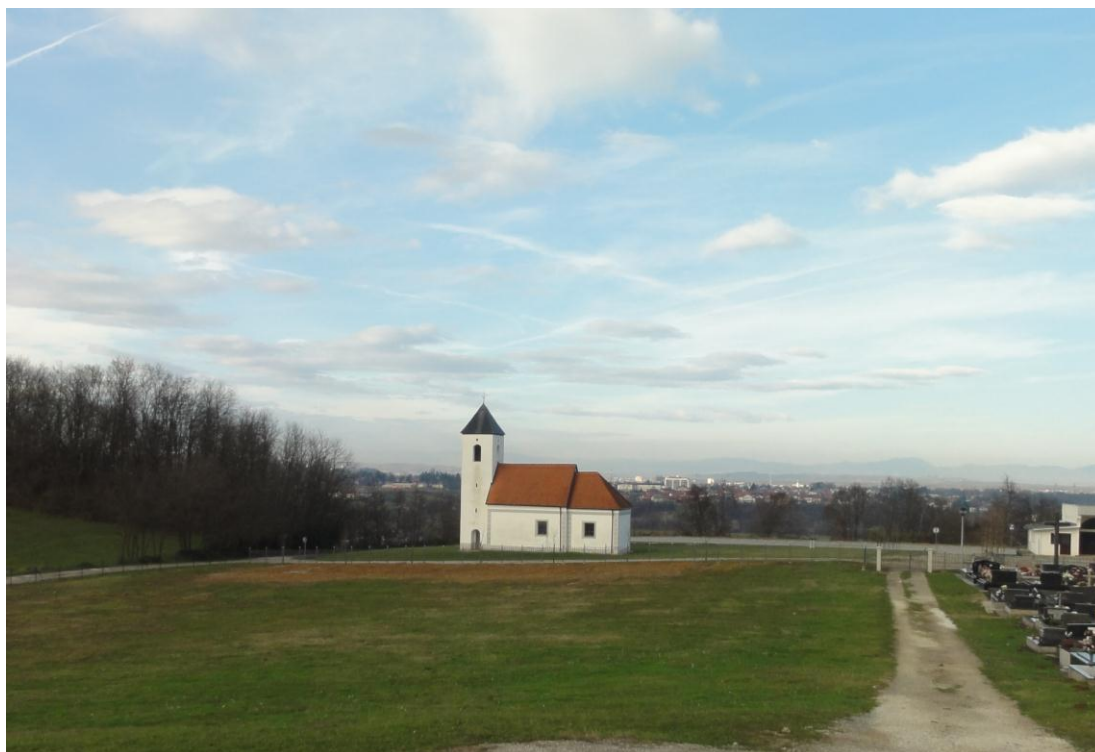
Prikaz kapelice Sv. Doroteje – pogled prema sjeveru na njeno južno pročelje
